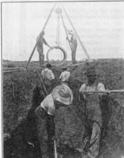
Figur 2.6 Udførelsen af en 36" beton-drænledning i Iowa, USA omkring 1913.
