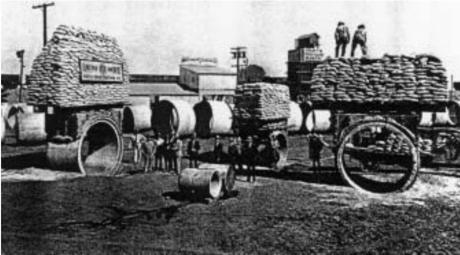
Figur 2.1 Trykprøvning af hhv. 102" og 108" betonafledningsrør ved Sacramento, Californien.
