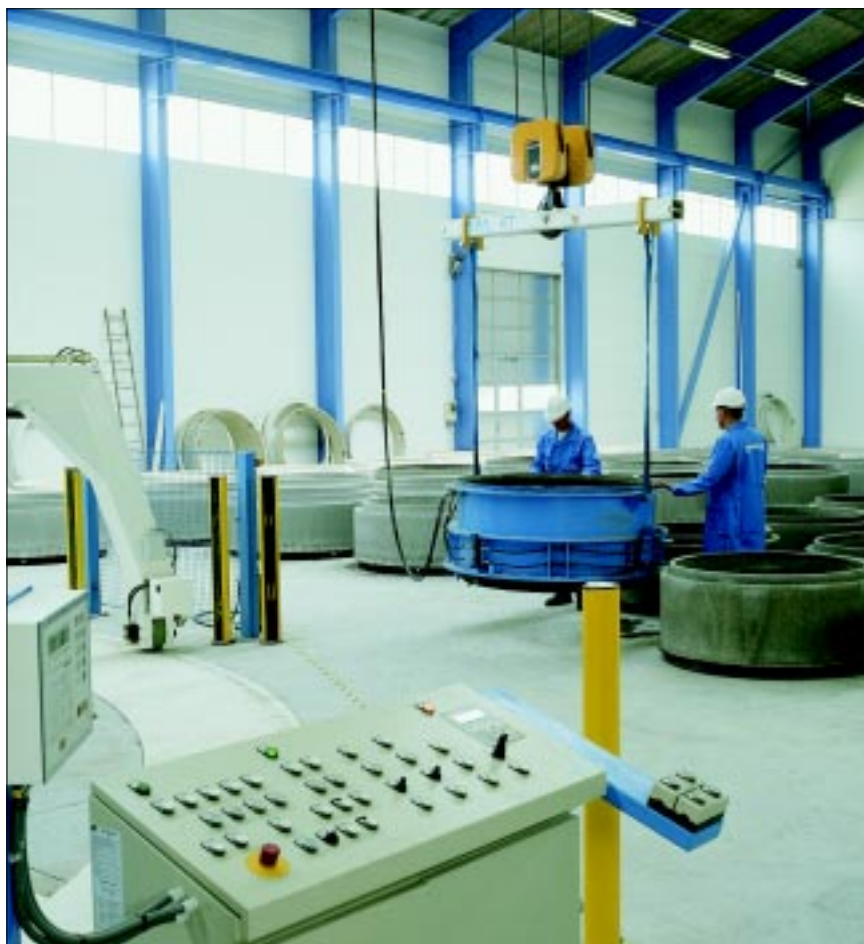
Dele af nyt produktionsanlæg til fremstilling af betonafløbskomponenter. Lyse, arbejdsmiljøvenlige lokaler. Anlægget er beliggende på Fyn.
