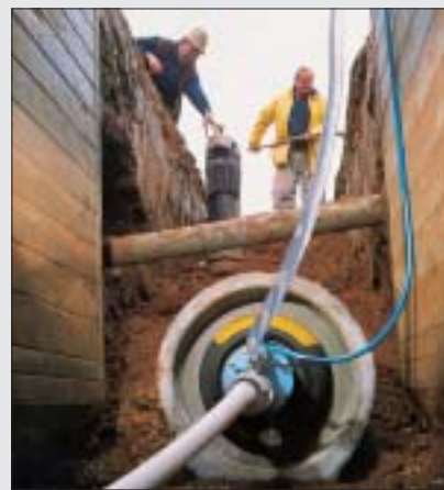
Tæthedsprøvning udføres let med specialudstyr. Her er der vist en vandtæthedsprøvning.
